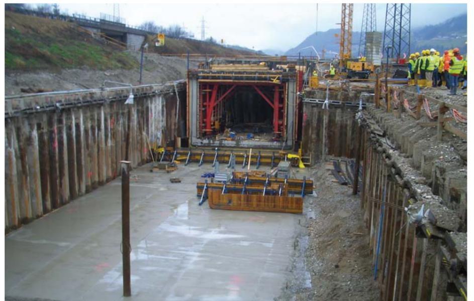
profile verbinden die Spundwandträger und die Zwischenprofile. C 9 Eckprofile wurden auf der Baustelle an die Hauptprofile aufgeschweißt, um die Ecken der Baugrube auszuführen.
