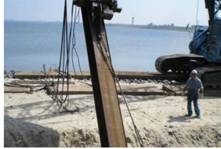
den 105 t AZ 13 10/10 Füllbohlen in S 355 GP in den Längen 27,9 bis 32,75 Meter Verwendung. Darüber hinaus lieferte ArcelorMittal 430 t Wellenspundwand. Im Einzelnen handelte es sich dabei um AZ 12, AZ 13, PU 18-1 und PU 32 Profile in den Güten S 355 GP und S 430 GP und in Längen zwischen 3 und 22,75 m. Nicht zuletzt wurden etwa 250 t HP Rammfähle von ArcelorMittal geliefert: HP 360 x 109 und HTM 600 x 136, Stahlgüte S 355 J2G3, in den Längen 20 bis 59,40 m.
